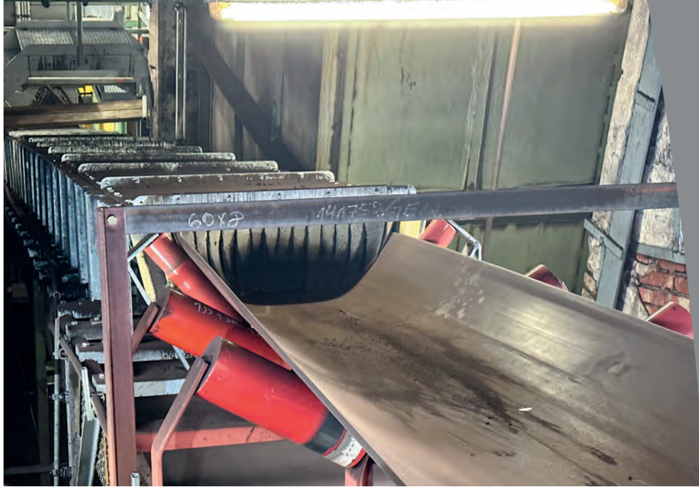
Umbau eines Muldengurtt Förderbands mit SafeLoad
